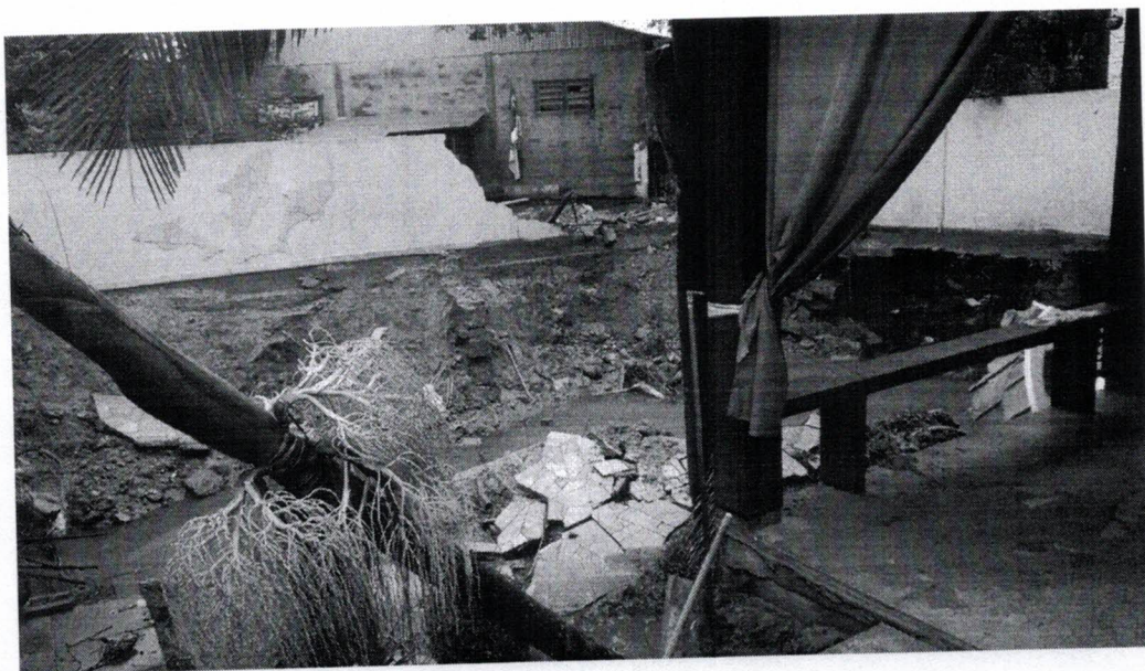
Fundos da residência na Rua Capitão Cruz, 2380
