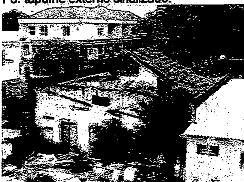
F8: vista superior, observando-se que resta somente pequeno segmento do telhado.
