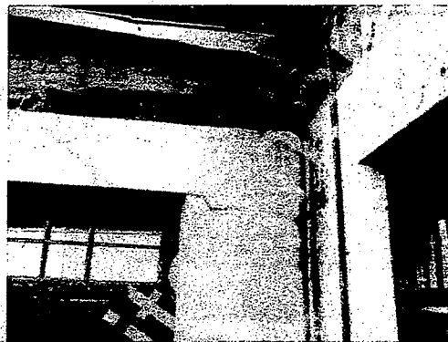
F23: observam-se fissuras horizontais na fachada.
