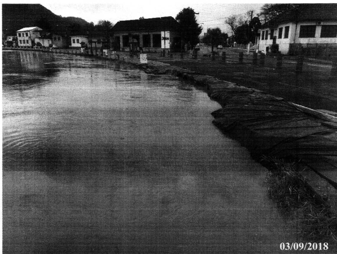
FOTO 6 – Talude do Rio Cai onde ocorreu o Colapso, com o rio no nível da cota de cheias (Foto tirada em Setembro/2018).
