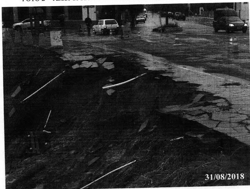
FOTO 3 – Talude do Rio Cai onde ocorreu o Colapso.
