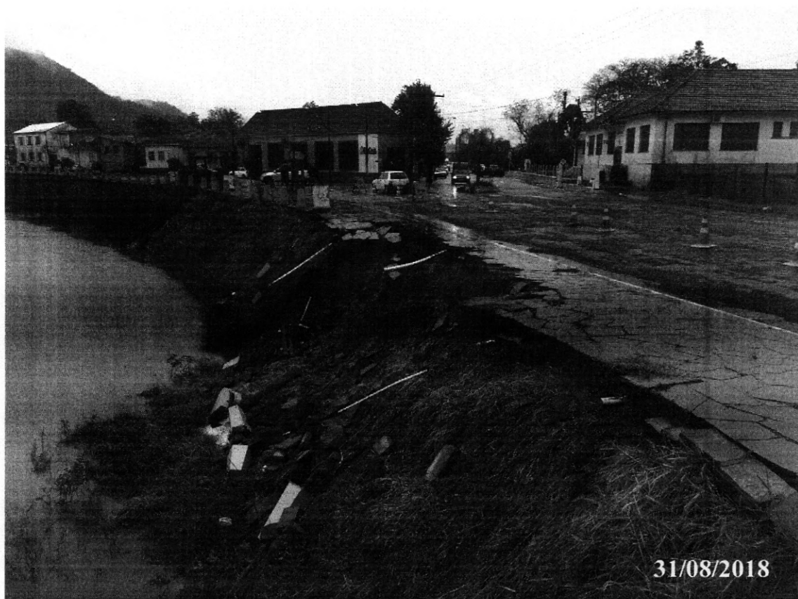
FOTO 1 – Talude do Rio Cai onde ocorreu o Colapso.
