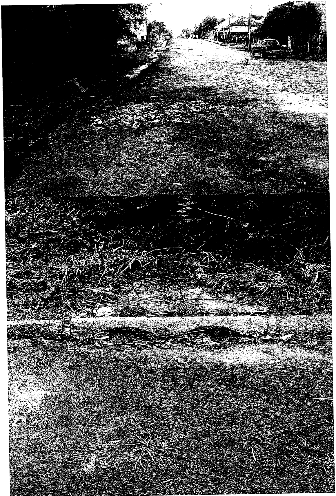
Rua Capitão Cruz, entre a Rua Cap. Machado e nr. 950, B. Centro.
