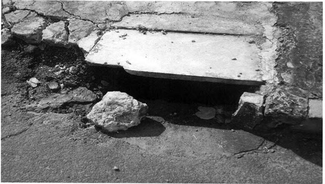
PP Conserto tampa de lobo e meio fio – Rua João Pessoa esq. Rua dos Plátanos-Centro.
